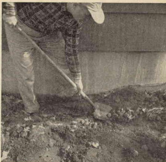
Il miglior sistema, sia di profilassi che di eliminazione delle termiti che possano essersi introdotte in casa consiste nel versare l'insetticida lungo una trincea abbastanza profonda, scavata attorno alla casa, a ridosso delle fondamenta. L'insetticida deve essere sufficiente per penetrare sino alla estremità inferiore delle fondamenta. La profondità della trincea dipende dalla maggiore o minore permeabilità del terreno.
