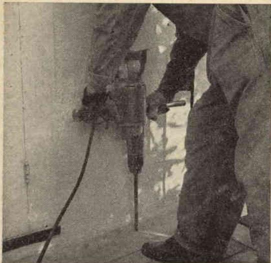
*Un grosso trapano come questo, ottenibile a prestito da qualche meccanico delle vicinanze può essere usato per praticare dei fori del diametro di 12 o 15 mm. nella soletta di cemento su cui la casa è costruita, in modo da poter iniettare nel terreno sottostante l'insetticida contro le termiti.*
