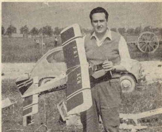
*Una felice realizzazione di Rosa Rosa Gioacchino. Modello radiocomandato con comando proporzionale. Ricevitore Gazistor autocostruito con valvole XFGI e transistor OC 70. Apertura c. Me mm. 1400 - Peso gr. 1700 - Motore K e B torpedo 19 cc. 3,28.*
